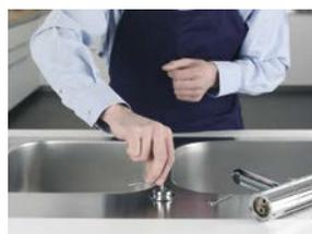
Avvitare il blocco con la chiave in dotazione. La base è ora installata.
